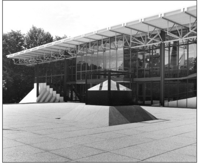
Situation, Foto Ostfassade, Übersicht Erdgeschoss
