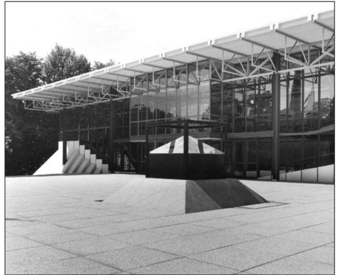
Situation, Foto Ostfassade, Übersicht Erdgeschoss
